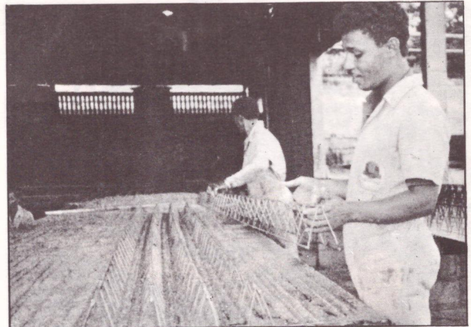
Figura 8 - Colocação das treliças
