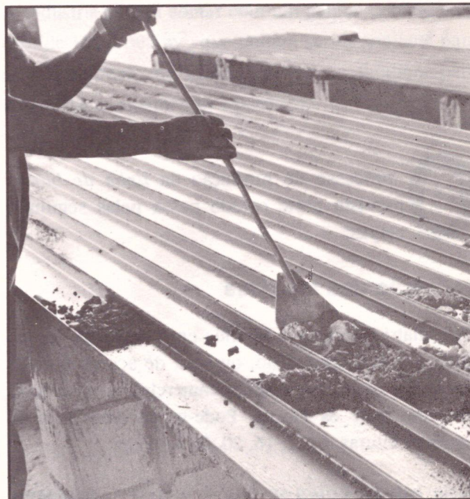
Figura 3 - Limpeza das formas
