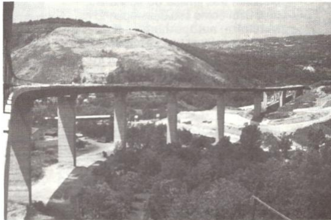
Viaduto de San Mango, Província de Avelino (Itália), realizado em estrutura mista - vigamentos de aço e tabuleiros em painéis Treliçados Autoportantes.
