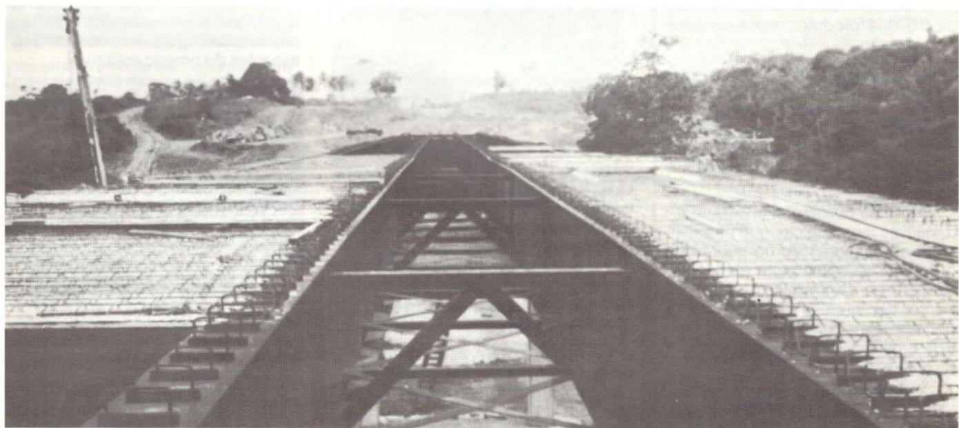
Vista geral de uma das pontes da "Linha Verde", com destaque para as Vigas Metálicas da Meso-Estrutura, prontas para receberem as Vigas Treliçadas Autoportantes.
