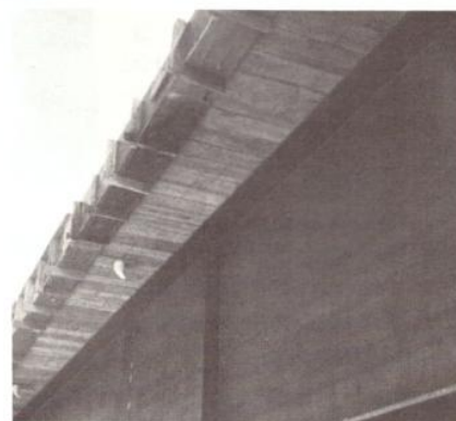
Vista inferior do balanço de 1,10 metros sem cimbramento durante a concretagem.
