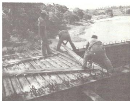
Montagem do tramo lateral da Meso-estrutura com 3 metros de vão e 1,10 metros de balanço, sem qualquer escoramento.
