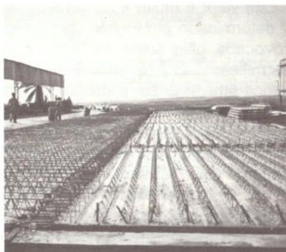
Vista geral da pista de fabricação das Vigas Treliçadas Autoportantes no canteiro de obras.
