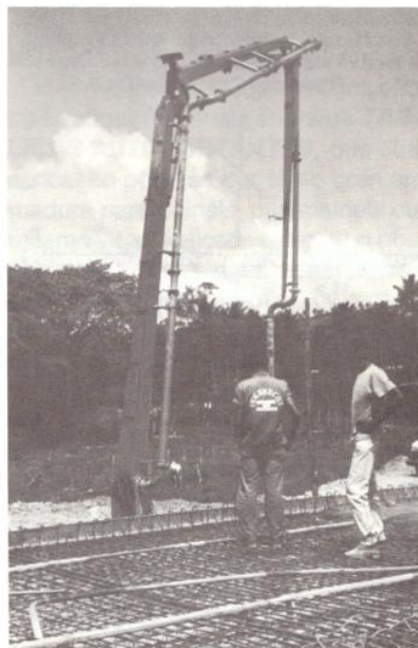
Lançamento do concreto após a montagem da armadura final do tabuleiro.
