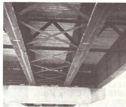
Vista inferior da ponte após a concretagem. Notar a total ausência de cimbramento e o perfeito acabamento inferior das Vigas Treliçadas Autoportantes.
